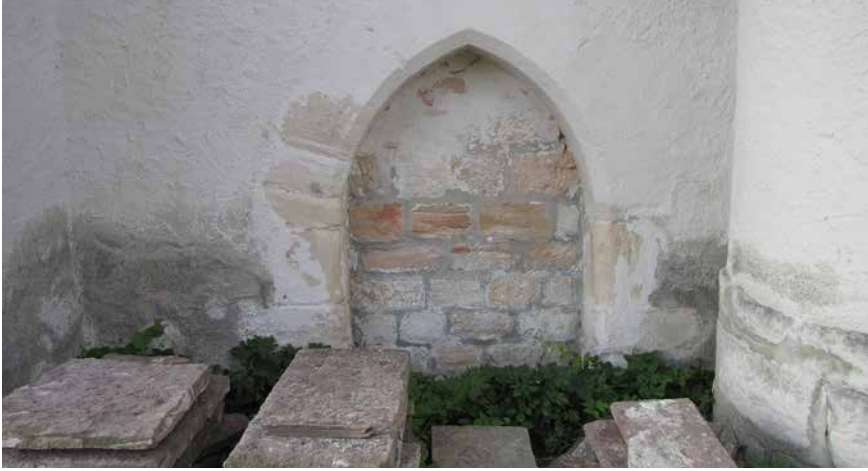
Abbildung 43: Hechingen-Stetten, Klosterkirche, Ansicht von Süden, Vermauerte Pforte im westlichsten Joch des Chors.
