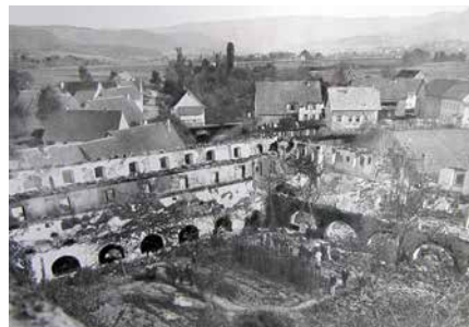
Abbildung 34: Kloster Stetten kurz nach dem Brand am 23./24. September 1898, Blick vom Dach der Kirche in südliche Richtung auf den abgebrannten Kreuzgang.
