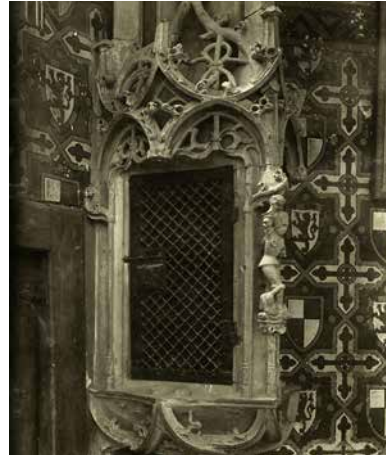
Abbildung 74: Sakramentsnische, Hechingen-Stetten, Klosterkirche, Sakramentshäuschen, Aufnahme um 1900.
